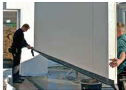
Absetzen der Wandtafel im Mörtelbett
