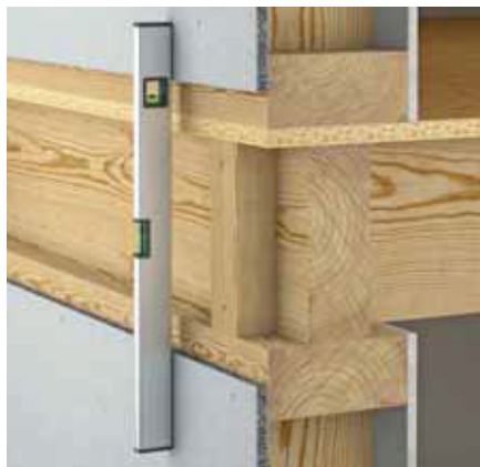
Bild 1: Ausrichten der Wandelemente
