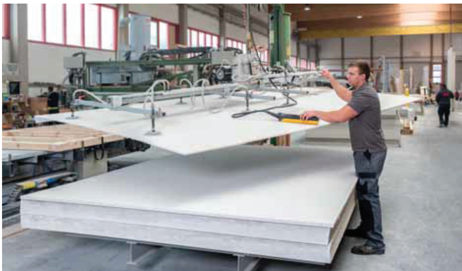
Transport von fermacell Gipsfaser-Platten mit einem Vakuumhebergerät
