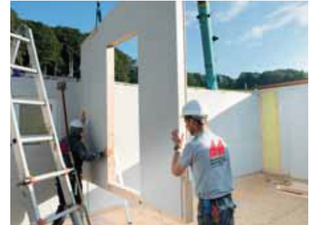
Montage auf der Baustelle
