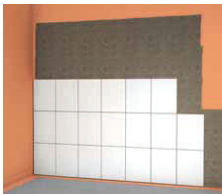
Verfliesung mit fermacell Flexkleber
