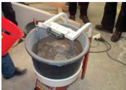
Anmischen fermacell Quellmörtel
