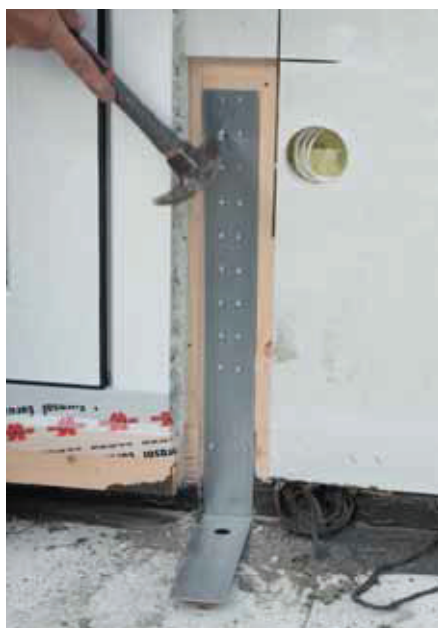
Montage Zuganker (Verdübelung Lastplatte noch nicht erfolgt)
