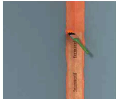
fermacell Dichtband in die zuvor aufgetragene, noch feuchte fermacell Flüssigfolie drücken und direkt mit Flüssigfolie überstreichen, Trocknungszeit: mind. 1 Stunde
