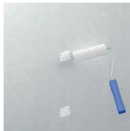
Deckendes Abtupfen der Verbindungsmittel in der Plattenfläche
