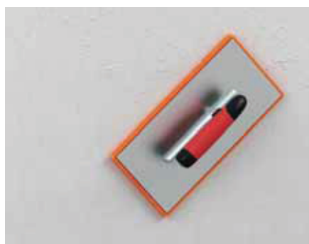
Abfilzen der Putzoberfläche mit einer Schwammscheibe
