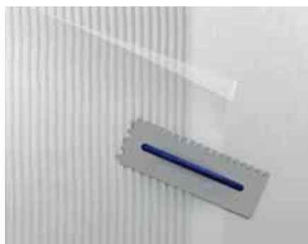
Überlappung des Armierungsgewebes mit ca. 100 mm
