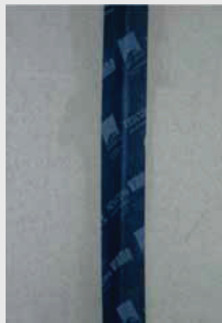
Luftdichte Abklebung einer Innenecke auf fermacell Vapor mit Primer
