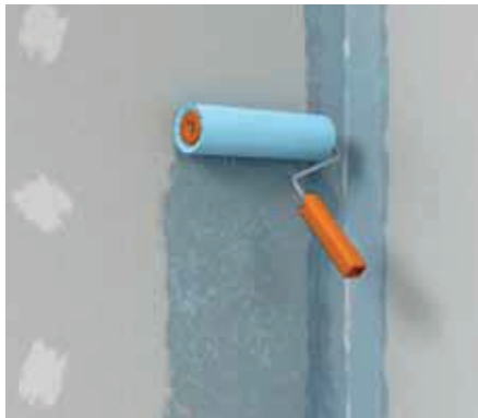
Vollflächiges Aufbringen des fermacell Tiefengrunds, Trocknungszeit: mind. 2 Stunden
