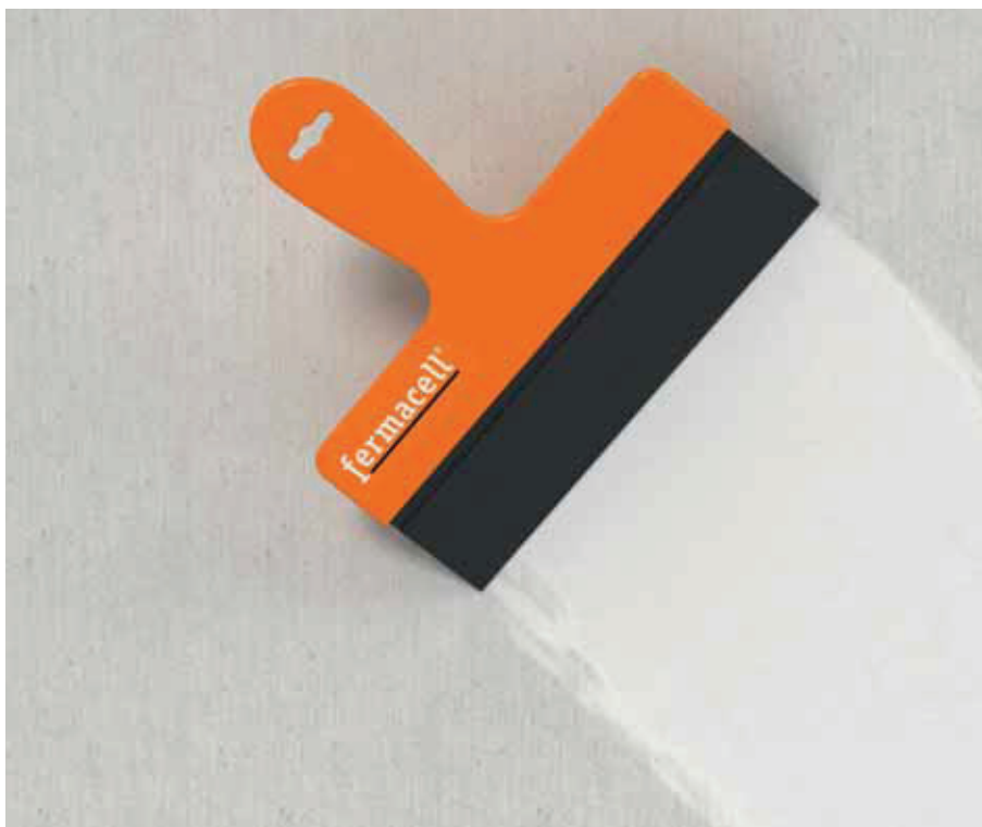
Flächenspachteln von fermacell Gipsfaser-Platten
