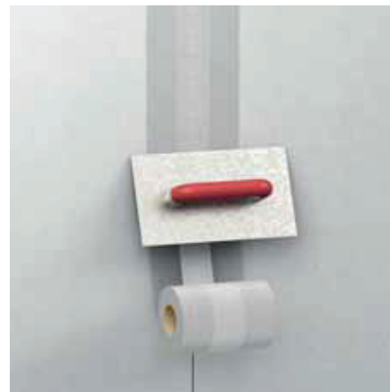
Aufbringen des fermacell Armierungsbandes HD
