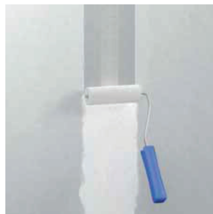
Aufrollen des fermacell Armierungsklebers HD
