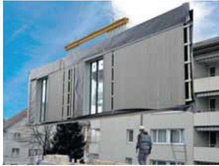
Krantransport auf der Baustelle
