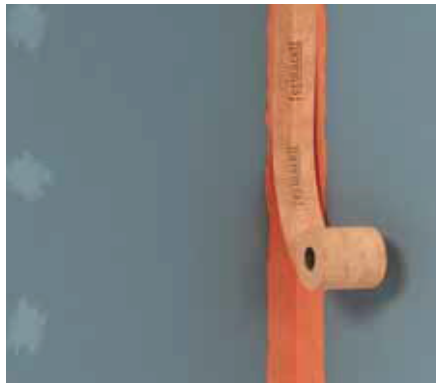
fermacell Dichtband in die zuvor aufgetragene, noch feuchte fermacell Flüssigfolie drücken und direkt mit Flüssigfolie überstreichen, Trocknungszeit: mind. 1 Stunde
