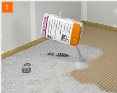
fermacell™ Wabenschüttung einbringen
