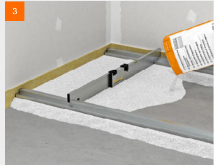
fermacell™ Ausgleichsschüttung einbringen
