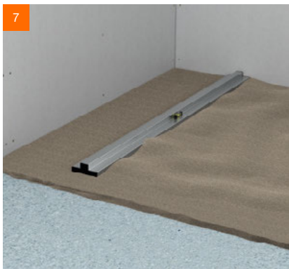
7 ... und auf den leicht verdichteten Dämmen abgezogen
