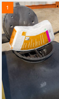
Mischungsverhältnis: 6 Säcke fermacell™ Wabenschüttung + 1 Gebinde fermacell™ Schüttungsbinder
