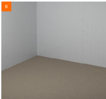
8 Nach dem selben Prinzip wird die gesamte Fläche mit fermacell™ Gebundener Schüttung T versehen
