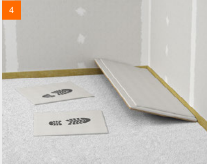
Verlegen der fermacell® Estrichelemente auf fermacell™ Ausgleichsschüttung
