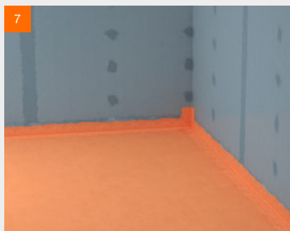
7 Bei der Verwendung von fermacell® Gipsfaser Estrichelementen in Klasse W1-I muss zusätzlich eine vollflächige Abdichtung erfolgen. fermacell™ Flüssigfolie mit der Rolle mind. 2 x vollflächig auftragen (Trockenschichtdicke mindestens 0,5 mm). Gemäß DIN 18534-3 wird für den 2. Auftrag ein Farbunterschied zur besseren Nachvollziehbarkeit gefordert. 1. Auftrag: fermacell™ Flüssigfolie in Originalfarbe satt auftragen und trocknen lassen.
