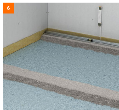
6 Ausrichten der Dämme
