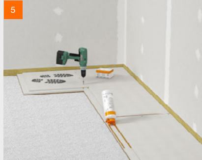
Verlegen der fermacell® Estrichelemente auf fermacell™ Ausgleichsschüttung
