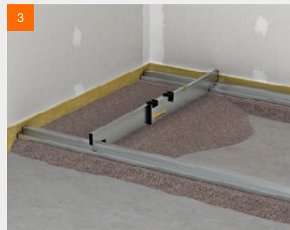
fermacell™ Gebundene Splittschüttung abziehen
