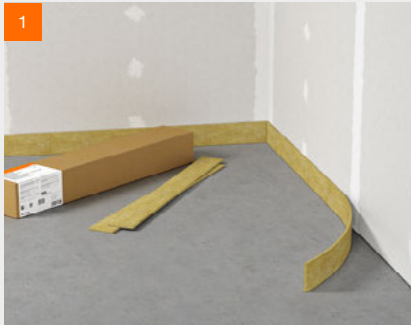
Anbringen der Randdämmstreifen
