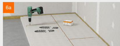
3 Verlegen der fermacell® Estrichelemente
