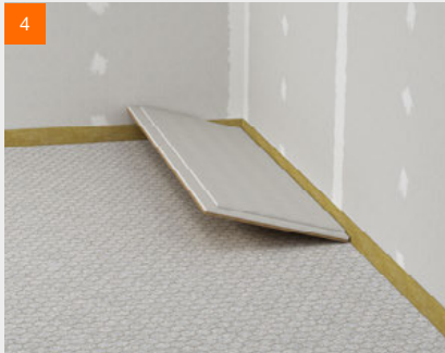
fermacell® Estrichelemente verlegen
