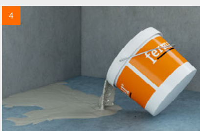
Boden-Nivelliermasse ausbringen und planeben nivellieren
