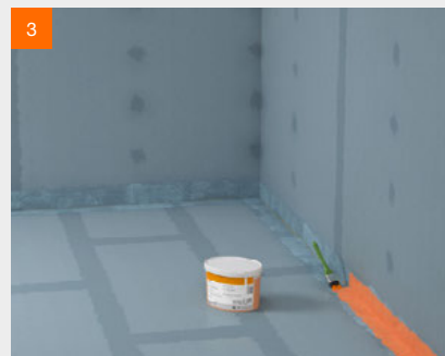
3 fermacell™ Flüssigfolie in der Ecke auftragen
