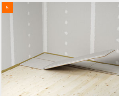
5 Verkleben der Elemente mit vollständig gefüllten Fugen
