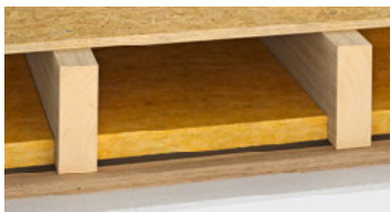
Geschlossene Holzbalkendecke, Unterdecke auf Lattung
