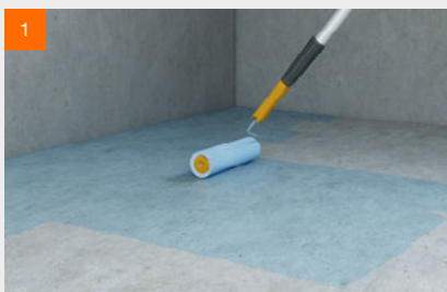
Vorbereitung: Boden grundieren
