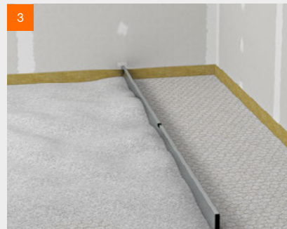
fermacell™ Wabenschüttung abziehen
