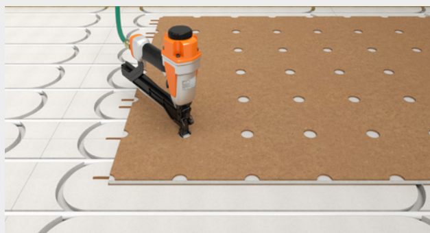
Montage der Abdeckplatte und mechanische Befestigung mittels Schrauben oder Klammern unter Verwendung der Schablone.
