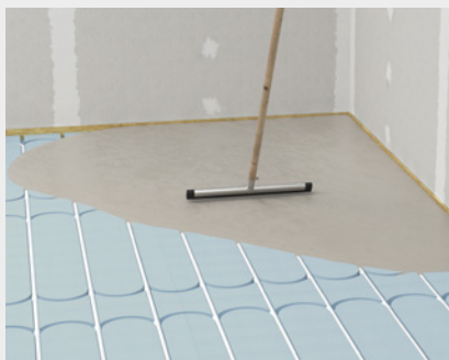
Ausgießen der Therm25™ Elemente mit fermacell™ Ansetzbinder
