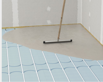
Ausgießen der Therm25™ Elemente mit fermacell™ Ansetzbinder
